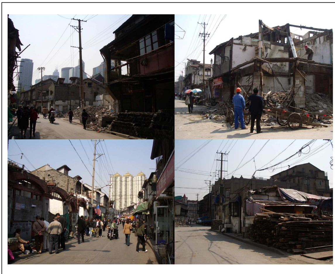
Photo 11 : La démolition de la Fang Bang Zhong lu au sein de la zone Xiangyuan Lu
